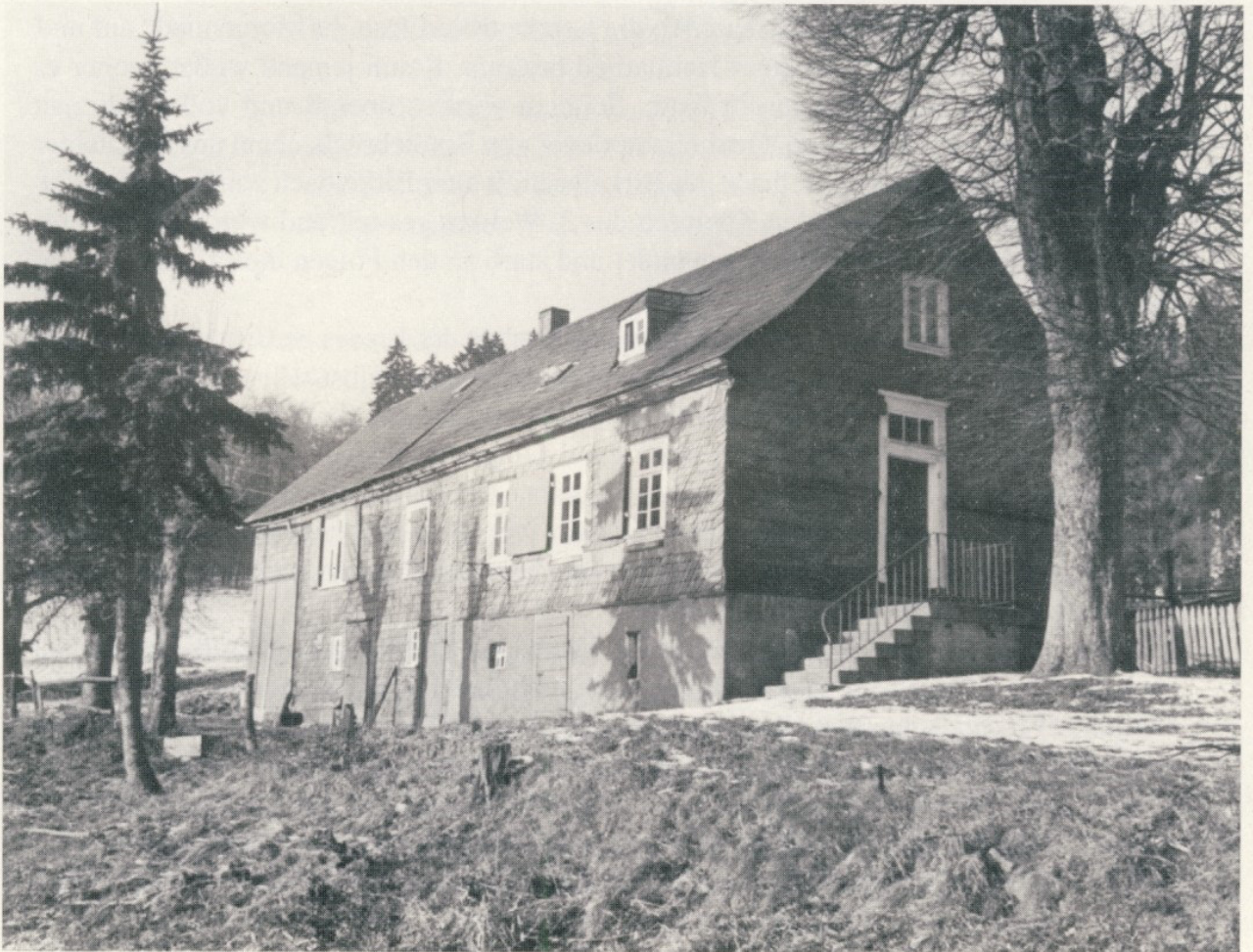
Forsthaus Foßnacker vor dem Abbruch 1969
